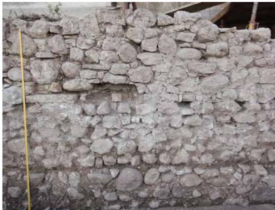
Fig. 8. Isera, villa romana. Particolare del tratto sud del muro perimetrale, alla cui base sfocia un condotto fognario orientato est-ovest (foto B. Maurina, 2020).
