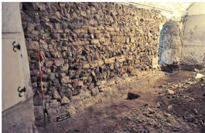
Fig. 8. Trento, palazzo Parisi Crispolti. Grossi blocchi in pietra utilizzati nella fondazione di un muro.
